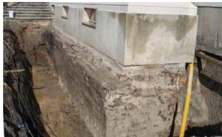
**Nach der Freilegung deutlich zu erkennen: das 2,65 Meter dicke Mauerwerk**
