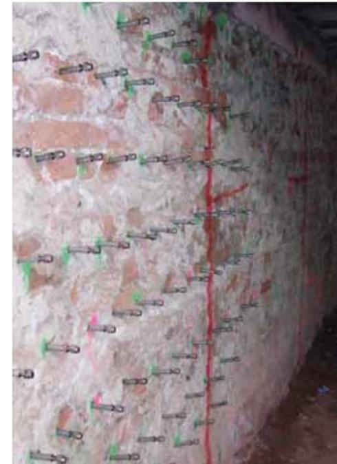
*Außenwände, die nicht mehr aufgedrungen werden können, um klassische Abdichtungsvarianten einzusetzen, werden heutzutage ebenso mit Schleier- oder Flächeninjektionen abgedichtet wie Bauteile, die zu tief in das Erdreich einbinden, als dass sich eine Freilegung wirtschaftlich lohnen würde. KÖSTER Anwendungstechniker Dipl.-Ing. (FH) Dirk Fischer stellt hier die Flächeninjektion vor.*
